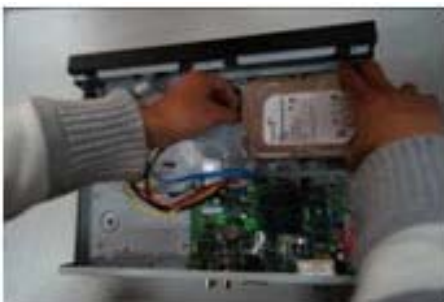
図 15-5HDD と電源ケーブルの接続
