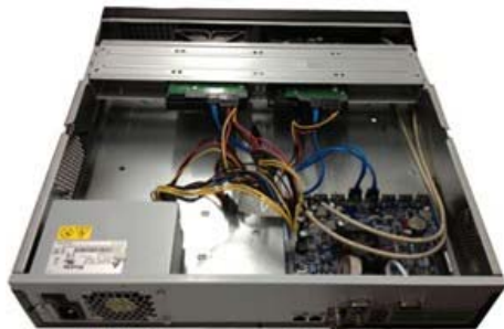
図 15-16HDD と電源ケーブルの接続
